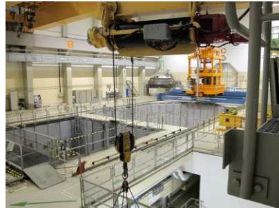
Mittels eines Krans mussten die Roboter in einen Reaktorbereich in 40 Meter Höhe gehievt werden.
